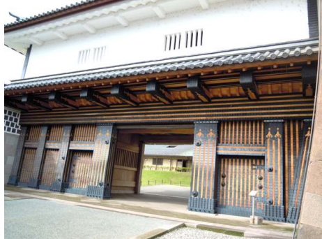
橋爪門全景(H27.3月完成)
