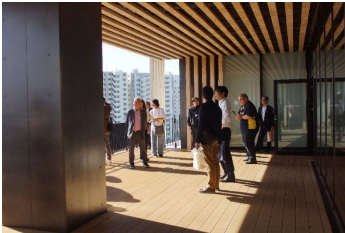
テラスには紀州材（無垢材）ルーバー
