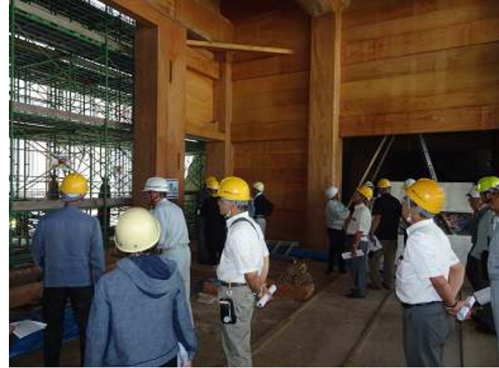
御楼門の1階部分、左側の大きな柱はケヤキの鏡柱(約87×66cm)
