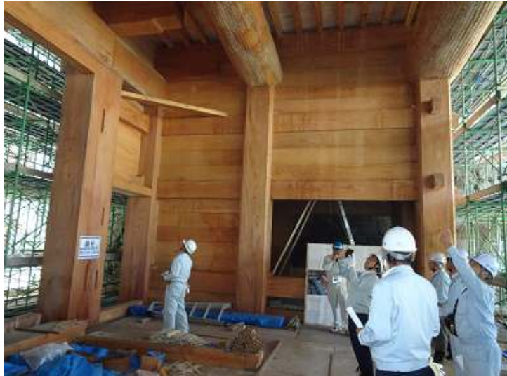
御楼門の1階部分、左側の大きな柱はケヤキの鏡柱(約87×66cm)
