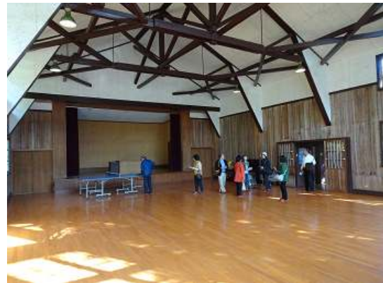
木造体育館(一部補修されている)
