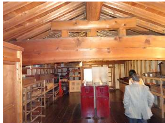
2階の梁と棟木には大径の杉を使用
